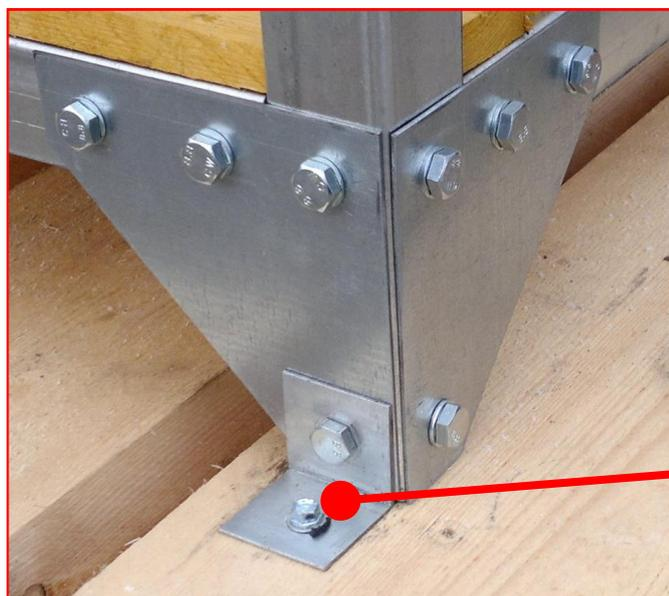
Крепления для надежной фиксации кабины к бетонному основанию или поддону.
